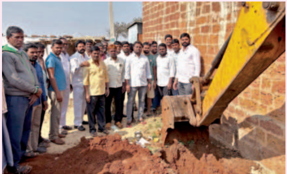
మురుగుకాల్వల నిర్మాణానికి శ్రీకారం చుడుతున్న సర్పంచ్ పీటర్ రాజు
